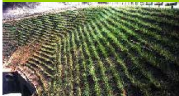
El Salvador – Un remblai d'autoroute traité avec le SV. De telles applications ont permis d'avoir une protection totale durant l'ouragan Mitch
