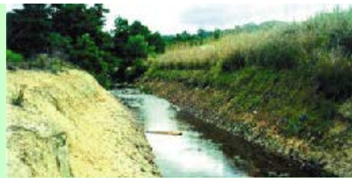
Australie- Le SV protège le côté droit d'une canalisation taillée à travers des sols sulfatés acides du Queensland. Comme on peut le constater, la berge gauche ne présente aucune végétation
