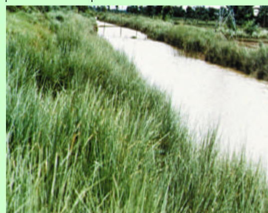
Bangladesh- des canaux d'irrigation protégés par le SV. Le vetiver y existe depuis un certain nombre d'années et rien n'indique qu'il est en voie de disparition
