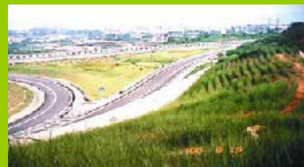
Chine- la même tranchée 12 mois plus tard. Cette tranchée était encline à beaucoup de glissements. Une stabilisation grâce au SV a permis d'apporter une protection totale
