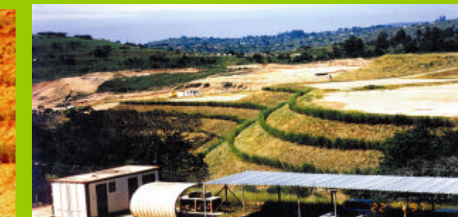
Afrique du Sud- stabilisation d'un chantier grâce au SV. Des espèces locales furent plantées entre les haies de vétiver
