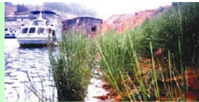
Australie- Le SV protège le côté droit d'une canalisation taillée à travers des sols sulfatés acides du Queensland. Comme on peut le constater, la berge gauche ne présente aucune végétation
