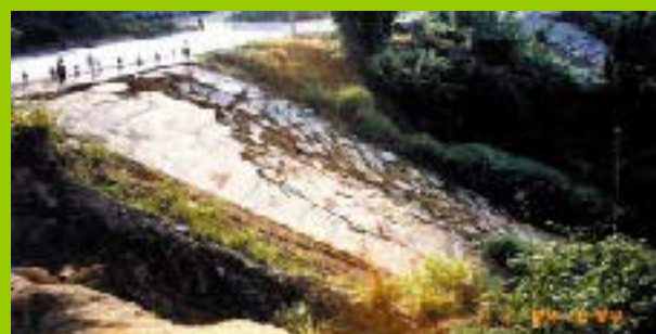
Chine- les procédés techniques sont onéreux et se brisent souvent lorsque les sols sont fragiles, en particulier pendant les fortes pluies
