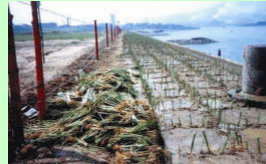
Chine- la digue sur l'image de gauche avait été retravaillée et des rangées de vétiver y furent plantées. Les rangées de vétiver avaient été plantées de manière perpendiculaire les unes par rapport aux autres
