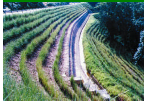
Malaisie – Stabilisation d'une autoroute
