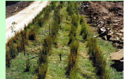
Australie- la même chaussée désormais stabilisée grâce aux rangées de vétiver. Les dégâts dus aux inondations furent minimisés
