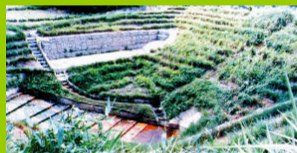
Malaisie- mise en place du SV dans les principales voies express à travers un système de drainage
