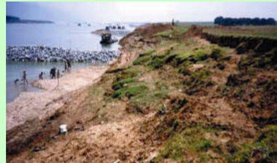
Chine- les digues qui protègent contre les inondations s'érodent abondamment et souvent se brisent en causant d'énormes dégâts économiques
