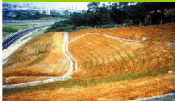
Chine- plantation récente de vétiver dans une tranchée autoroutière. Les sols sont très acides et enclins au glissement. De grandes quantités d'engrais permettent d'assurer une bonne croissance
