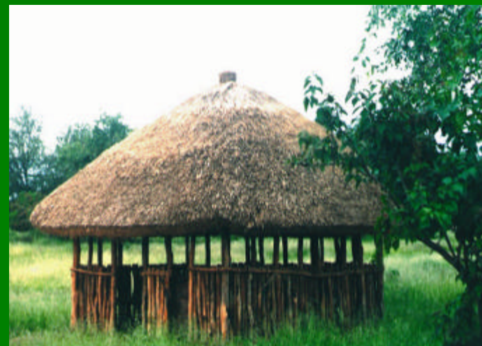
Zimbabwe- un lieu de rencontre à la toiture superbement recouverte de chaume à base de vétiver. Le chaume durera trois fois plus longtemps car il peut résister aux insectes et aux champignons
