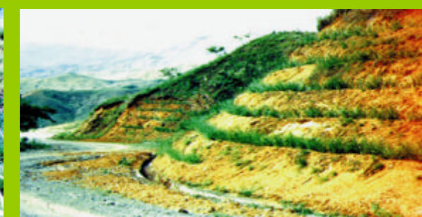
Philippines- mise en place du SV au niveau des tranchées d'autoroutes qui furent endommagées par des tremblements de terre
