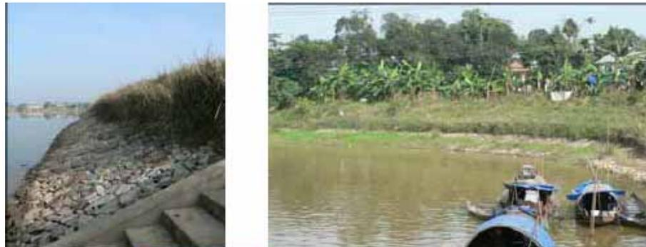
图 3-14：香根草保护的堤坝，堤坝下部是混凝土坝基，上部则是香根草和砌石的结合结构(左)；顺化“香水河滨”河湾一景，对面是香根草护坡景观(右)
