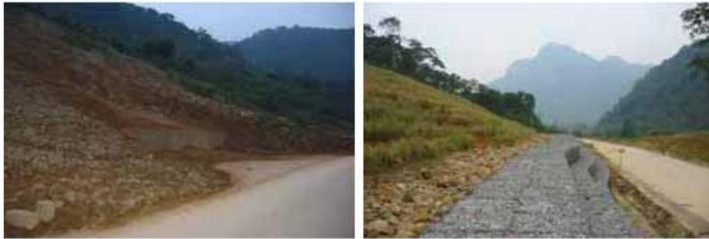
图 3-25: 植被破坏后, 在广平 Da Deo 山口的开挖坡地连续地发生极严重的崩塌(左); 自从在崩塌坡面种植一行行香根草后, 坡地慢慢变得坚实, 崩塌土体明显减少(右)
