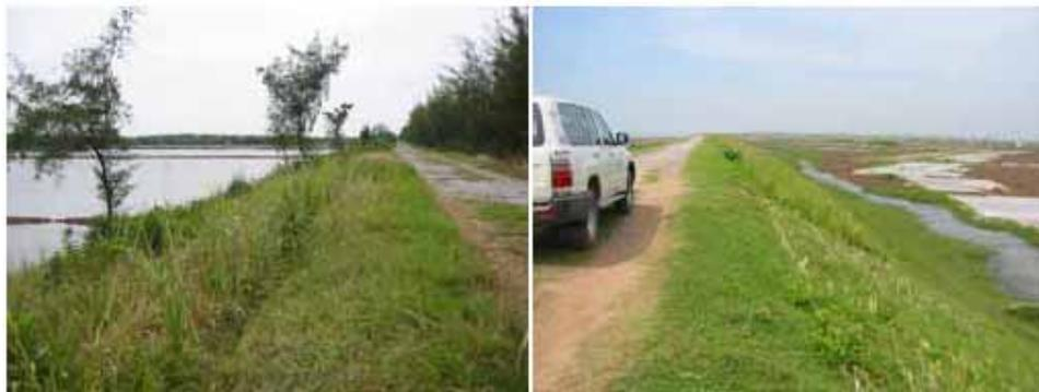
图 3-22： 越南北部南定省，新修海堤外侧栽植的香根草(左)；
