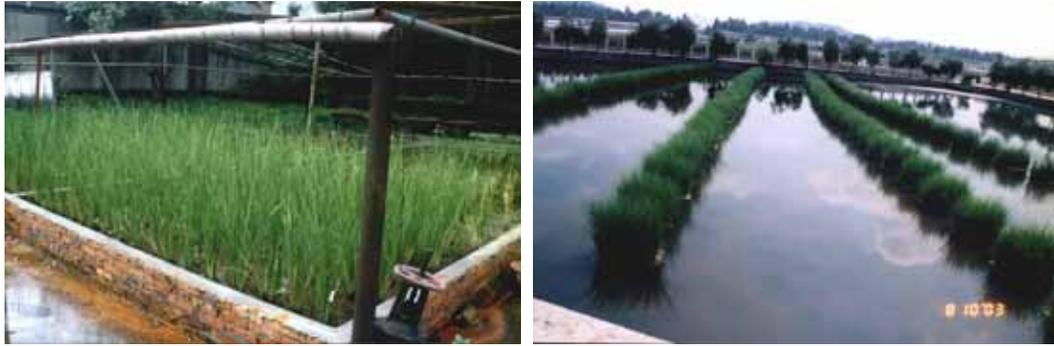
图 6-13: 香根草人工湿地用于处理工业炼油废水(左), 香根草浮床处理猪粪场废水(右)
