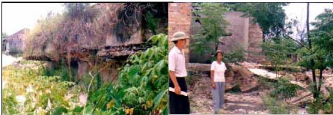
图 3-6：1999 年 Le Thuy (广平) 的流沙使水泵站的地基暴露(左)；
