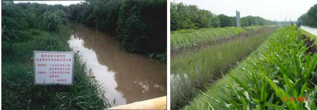
图 6-18：广州赢洲生态公园开展河涌生态改造试验示范(左)；改造后的河涌景观，香根草长在河道两边，不仅固土护坡、净化污水，还美化环境(右)
