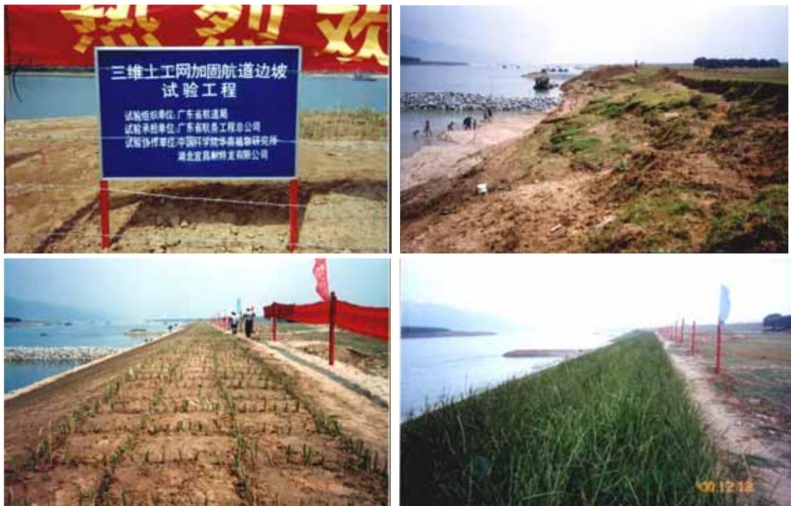
图 6-17：在北江大堤广东三水段开展的航道边坡加固工程
