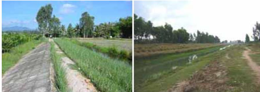
图 3-16: 防盐堤上游面向河水面用传统砌石和混凝土护坡的堤坝(左); 与其相对的渠岸因表面侵蚀已变得面目全非(右)
