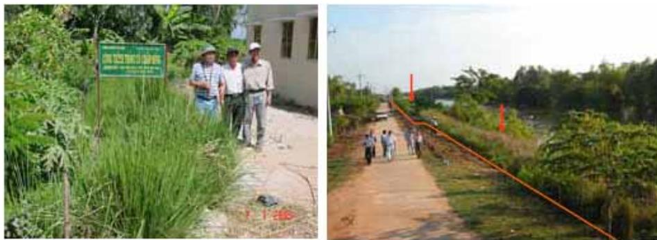
图 3-20：沿洪灾安置中心边坡种植的香根草绿篱(左)；红线显示约有 5 m 的范围受香根草保护而未被水毁(右)
