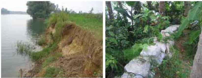
图 3-17: Tra Khuc 河在 Binh Thoi 社区的一段, 河岸受到严重侵蚀(左); 当地农民用最传统而原始的沙包保护河堤(右)
