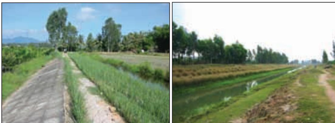
**Photo 12 : Section en amont d'une digue anti-sel avec enrochement traditionnel en béton en face de la rivière (gauche) et le long d'une section du canal d'irrigation, l'érosion de surface marque la berge opposée (droite)**
