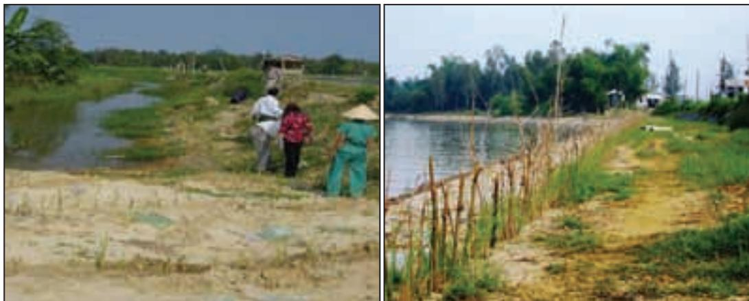
**Photo 8 : Gauche : Mars 2002 : Essai de SV au bord d'un étang à crevettes, où un canal draine l'eau de la crue à Vinh Dien River ; droite : Novembre 2002 : plantation en masse combinée à l'enrochement pour protéger la berge le long de la rivière Vinh Dien**
