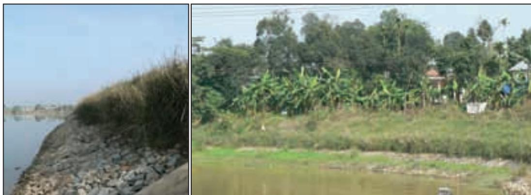
**Photo 10 : Gauche : Le vétiver et l'enrochement (en haut) et le cadre en béton (plus bas) protègent un remblai droite : un virage sur la berge de la rivière parfumée à Hue**
