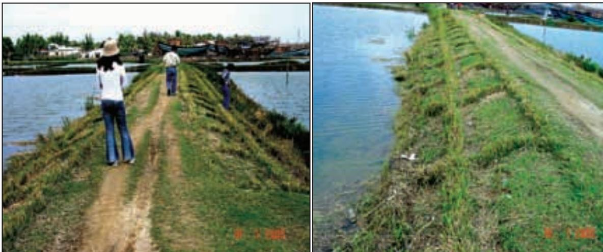
**Photo 22 : Le vétiver, installé dans un forme de triangles croisé é, protège les digues de l'étang à crevettes à Quang Ngai**
