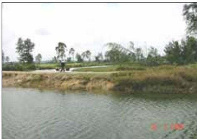
**Photo 23 : La section droite de cette route rurale à Quang Ngai est protégée par le vétiver ; la section gauche n'est pas protégée**
