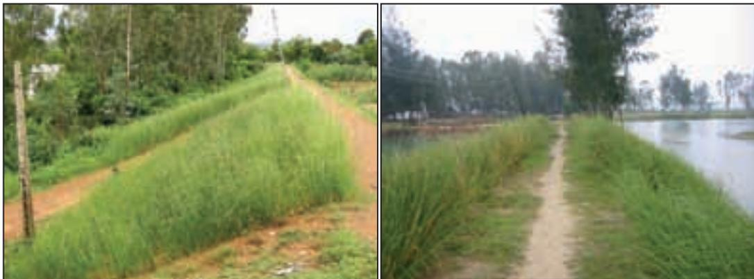
**Photo 11 : Gauche : Vétiver planté sur une digue de rivière au bord du Tra Bong ; droite : alignés sur les bords d'une digue d'estuaire anti-sel au bord de la même rivière**
