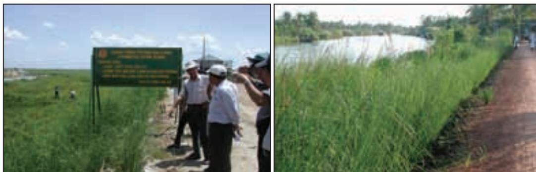
**Photo 15 : A An Giang, le vétiver stabilise une digue de rivière (gauche), et une berge naturelle (droite)**
