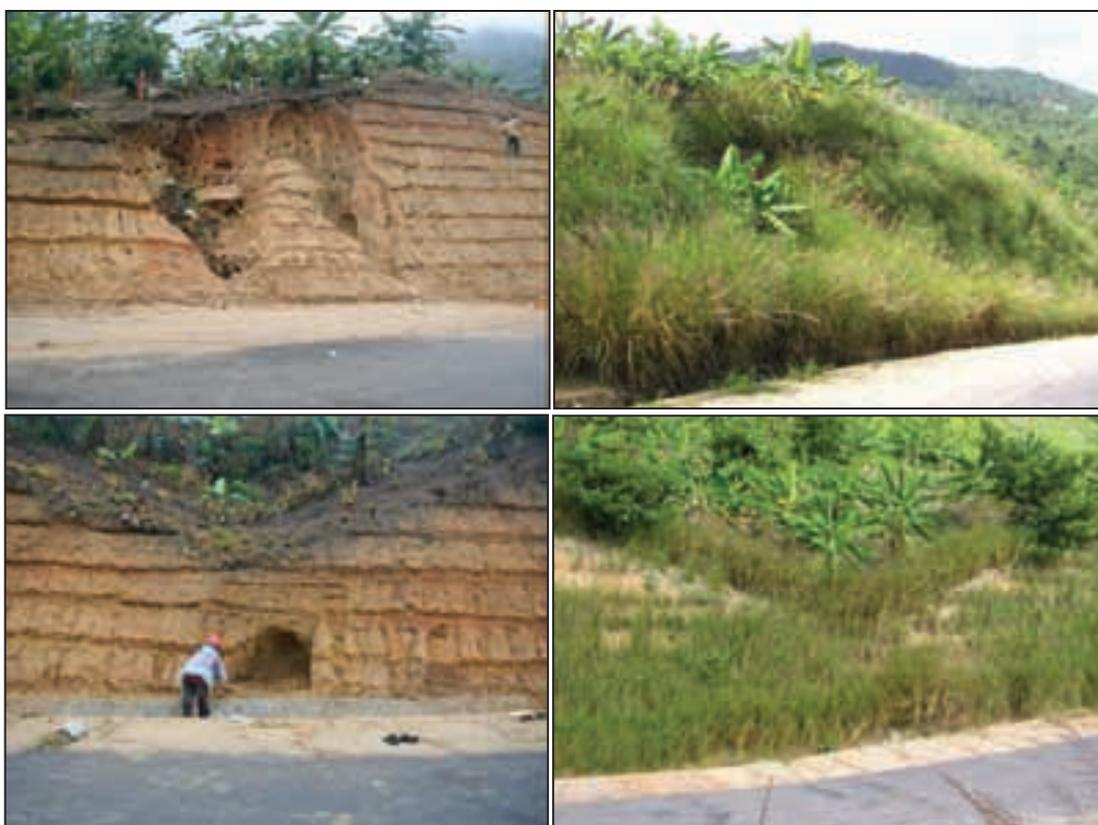
**Photo 22 : Pham Hong Duc Phuoc, un projet de protection de route dans la province de Khanh Hoa, route de Hon Ba) : gauche deux photos : érosion sévère sur un talus construit survenant après seulement quelques pluies ; droite deux photos : huit mois après la plantation de vétiver : le vétiver a stabilisé cette pente, en arrêtant et en prévenant totalement une nouvelle érosion pendant la saison humide suivante**
