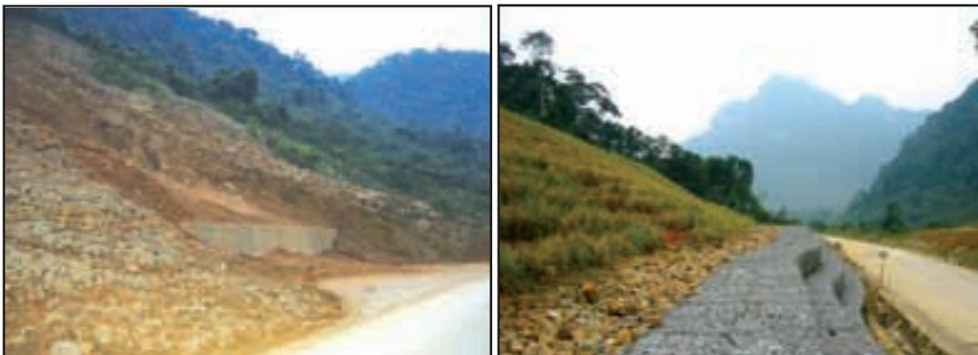
**Photo 21 : Da Deo Pass, Quang Binh : Gauche : La couverture végétale est détruite, révélant des ruptures inesthétiques et continues de pentes coupées ; droite : Rangées de vétiver au sommet de la pente lentement resserrées vers le bas, réduisant considérablement la masse affaissée**
