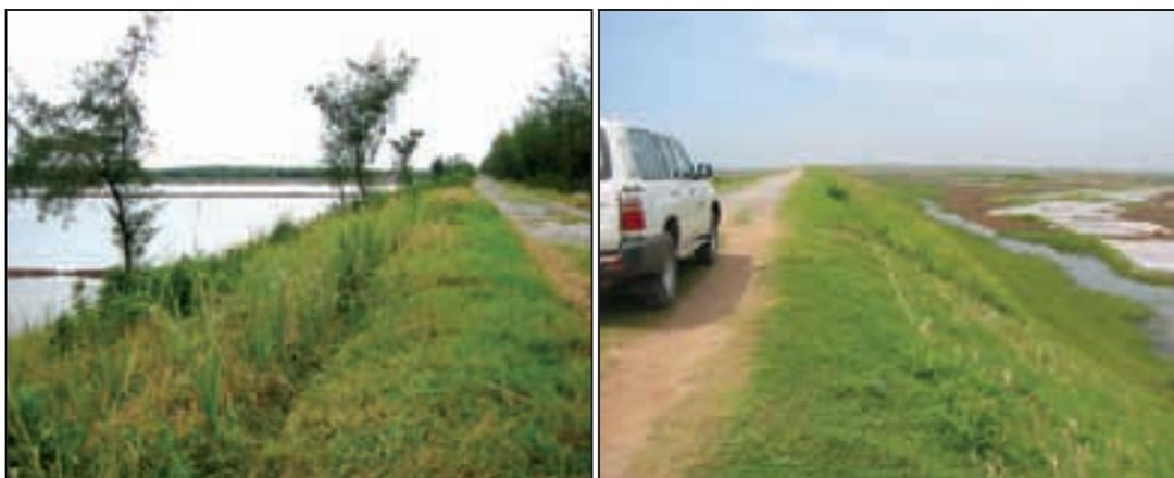
**Photo 18 : Au Nord du Vietnam ; gauche : Vétiver planté sur le côté extérieur d'une digue maritime nouvellement construite dans la province de Nam Dinh ; droite : sur le côté extérieur de la digue, planté par le Département local des digues**
