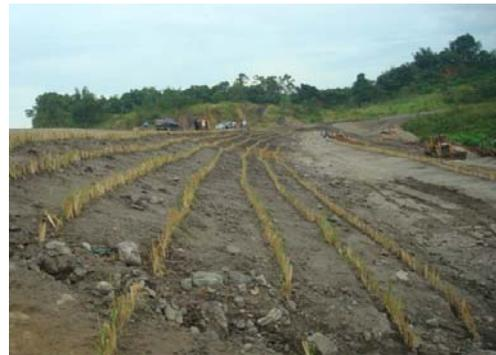
*Foto 20 : 100.000 slip vetiver ditanam untuk menstabilkan tanah liat dan tanah serpih untuk melindungi lereng dan jalan akses sebelum pembangunan kontruksi perumahan yang sangat besar ini*
