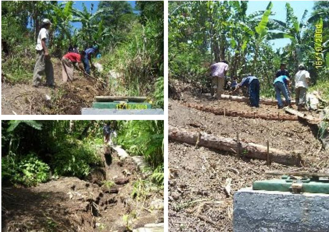
**Foto 11:** Kiri atas: February 2004, erosi pada mata air pegunungan sebelum ditanami Vetiver. Kiri Bawah: Penggalian sisi saluran air. Kanan: Pembuatan teras dengan balok kayu
