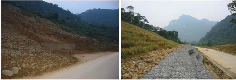
**Foto 21: Da Deo Pass, Quang Binh: Kiri: Vegetasi penutup yang hancur, menunjukkan hasil buruk dan longsor lereng buatan yang terus menerus; kanan: Baris Vetiver di lereng paling atas secara perlahan menekan ke bawah dan cukup banyak mengurangi longsor yang besar**
