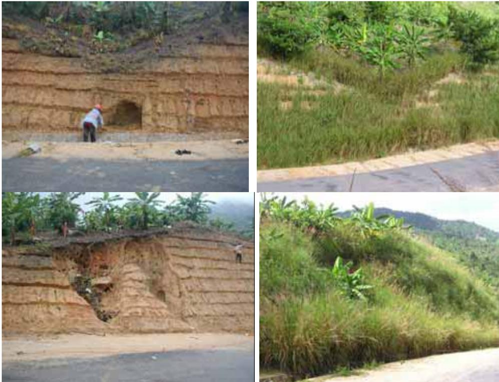
**Foto 22: Pham Hong Duc Phuo, proyek perlindungan jalan di propinsi Khanh Hoa, jalan menuju Hon Ba): kiri dua foto: erosi yang parah pada lereng penahan yang baru dibangun yang terjadi hanya setelah beberapa kali hujan; kanan dua foto: delapan bulan sesudah penanaman Vetiver: Vetiver menstabilkan lereng ini, benar-benar menghentikan dan mencegah erosi lebih lanjut di musim hujan berikutnya.**
