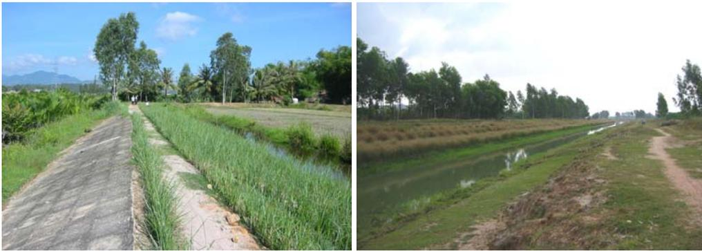
**Foto 12:** Tanggul anti-salinitas hulu dengan talud beton menghadap sungai (kiri) dan sepanjang satu bagian kanal irigasi, erosi permukaan merusak tepian di ujung lain.
