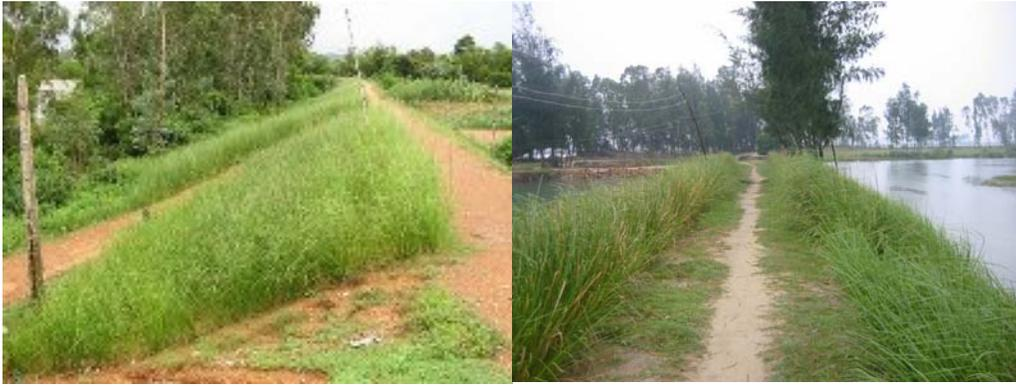
**Foto 11:** kiri: Vetiver ditanam di tanggul sungai sepanjang sungai Tra Bong; kanan: memagari sisi tanggul muara anti-salinitas di sepanjang sungai yang sama
