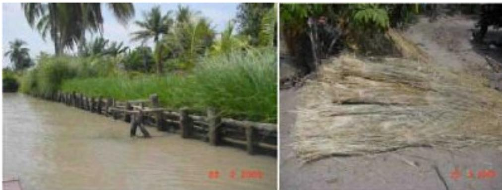
**Foto 30: Kiri: Vetiver menguatkan struktur kayu di sepanjang sungai; kanan: potongan daun Vetiver menjadi tali untuk mengikat padi**
