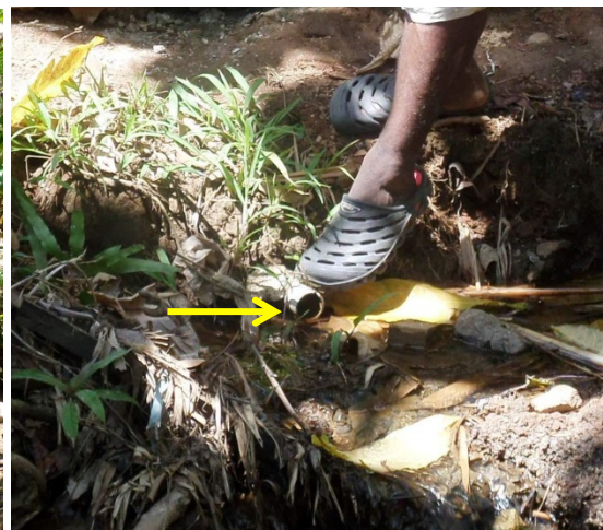
Toilet outlet pipe
