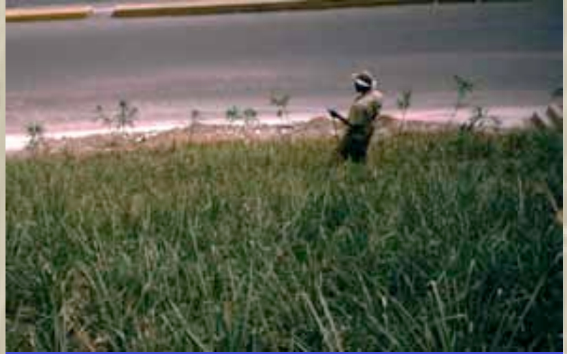
Protección de talud en el Club Magnum en Caracas, Autopista de Prados del Este
