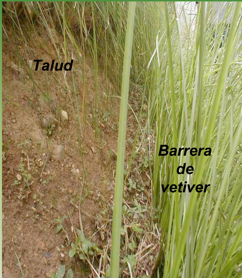
Deslizamiento estabilizado con barrera de vetiver
