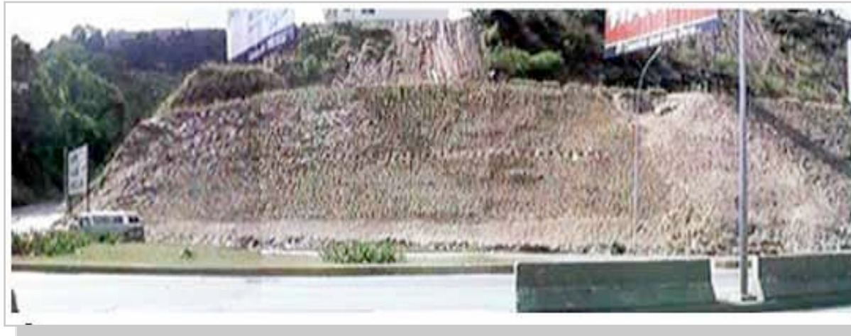
Condición inicial del área, 1996
