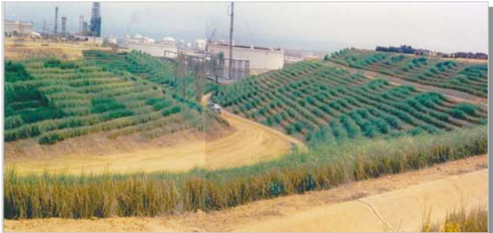
Barreras vivas de vetiver y pasto bermuda con obras hidráulicas Zonas Sur y Oeste del proyecto
