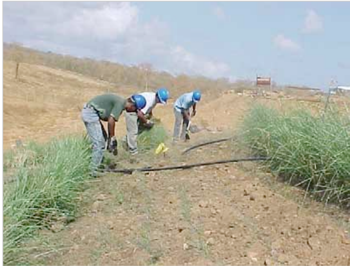
Ajuste del sistema de riego entre las especies vegetales (barreras vivas de vetiver y pasto bermuda)
