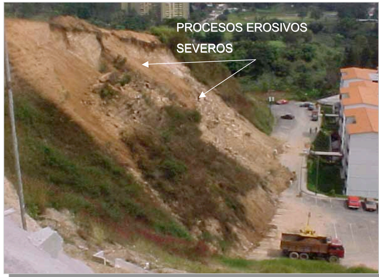
Condición inicial del área
