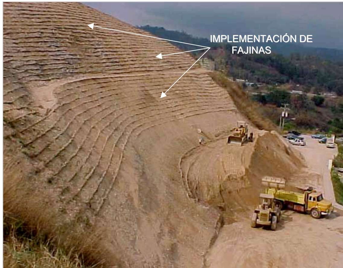
Condición del área una vez conformado los taludes, 2005
