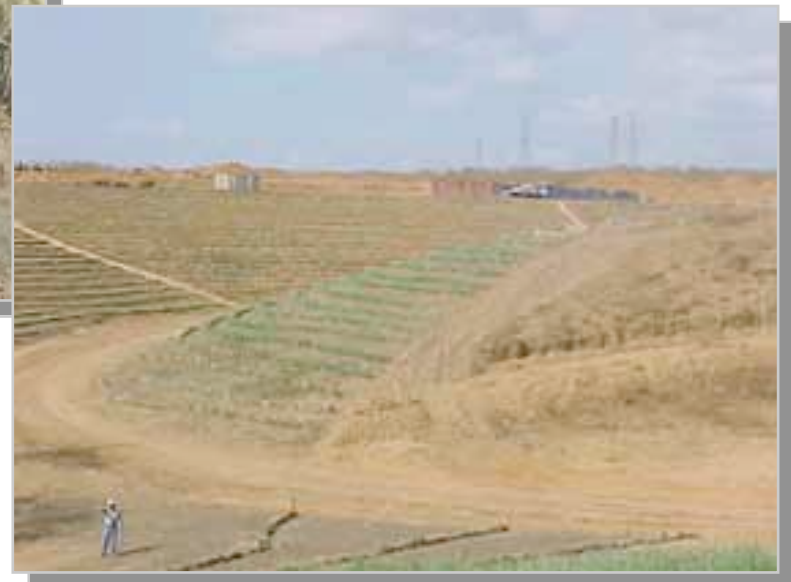
Establecimiento de barreras vivas de vetiver en áreas de talud
