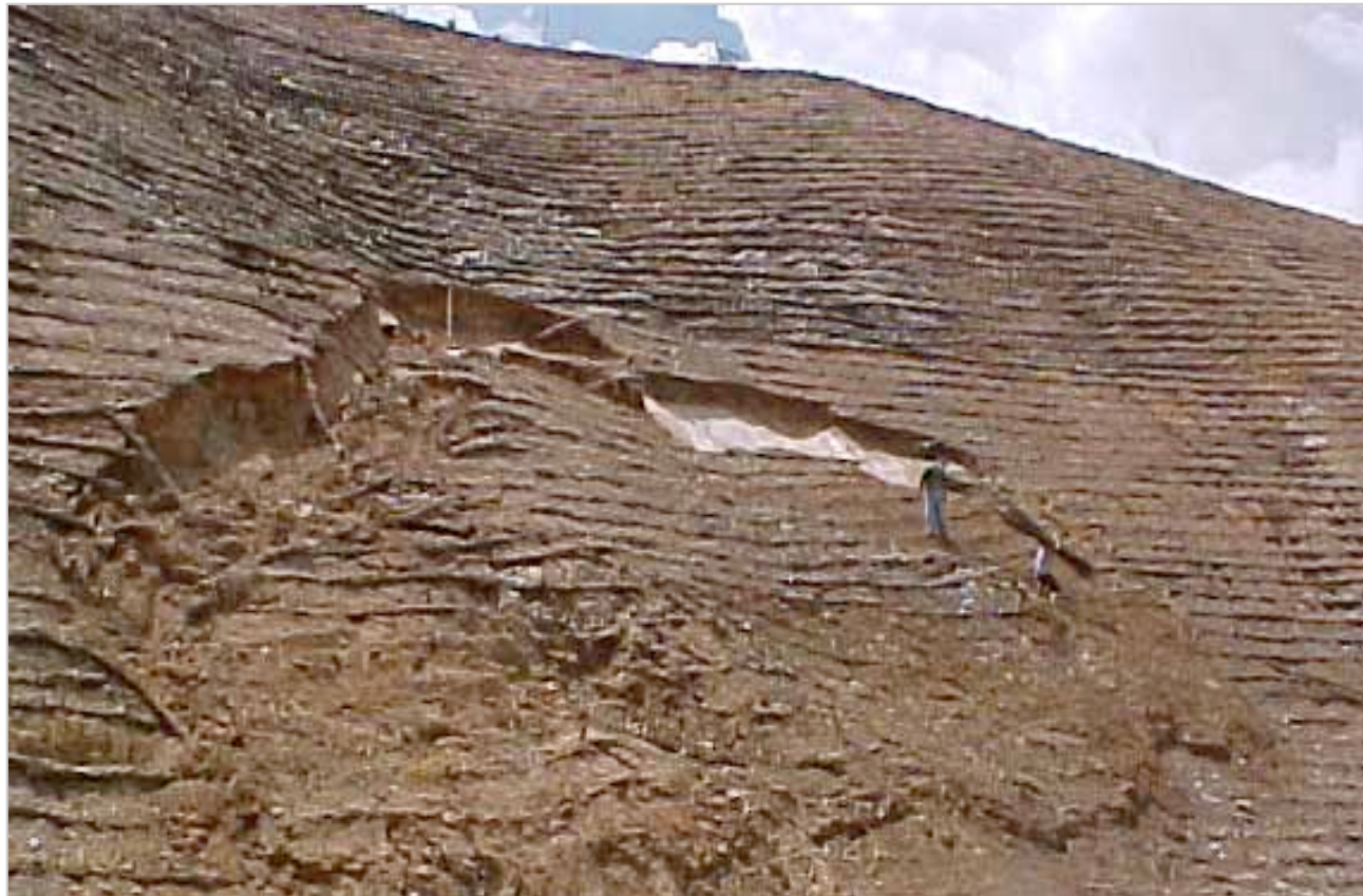
Condición del área de talud, luego del deslizamiento
