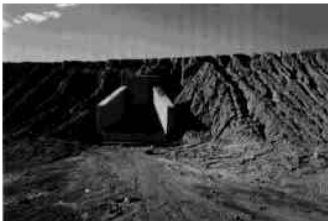
Erosión Pista Sub – Urbana
