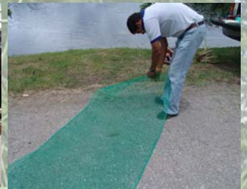
2. Malla plástica para sostener la macolla
