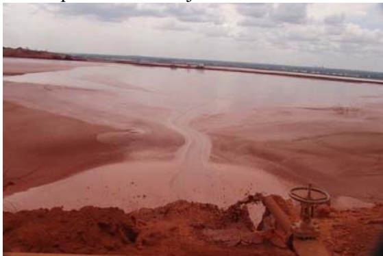
Foto n°2 Sistema lagunar de descarga y almacenamiento de los Lodos Rojos.
