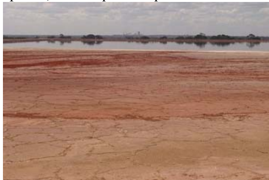
Foto n°2 Sistema lagunar de descarga y almacenamiento de los Lodos Rojos.
